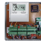
Płytkę sterującą, transformator mocy, listwa zaciskowa
